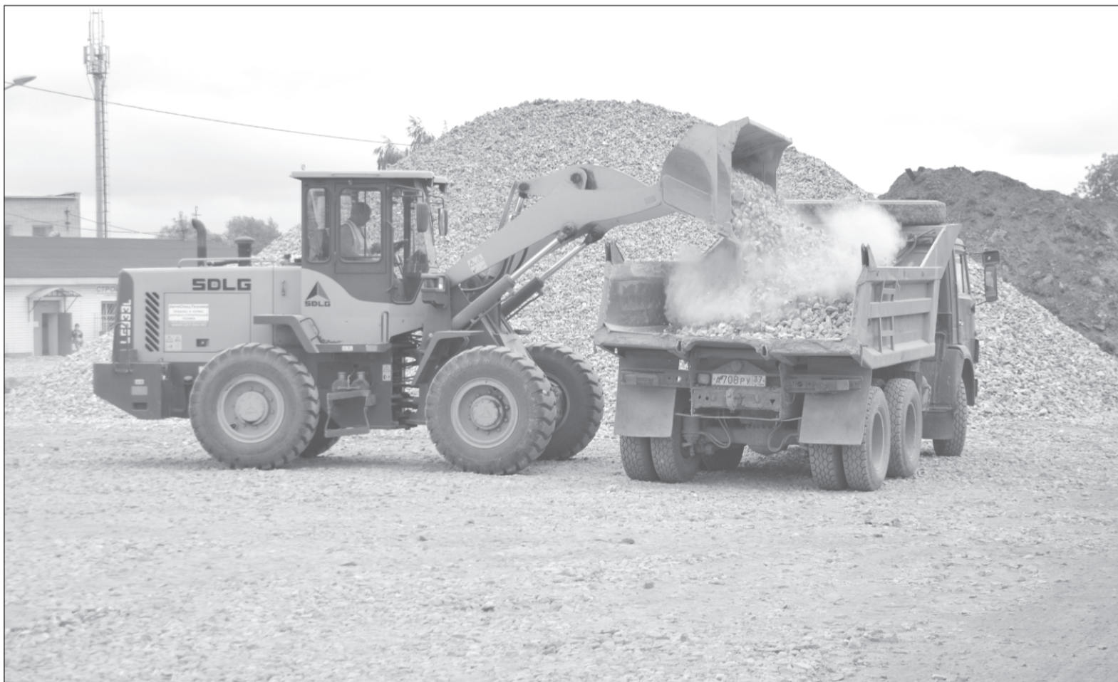
Работы на объекте ведутся допоздна.
